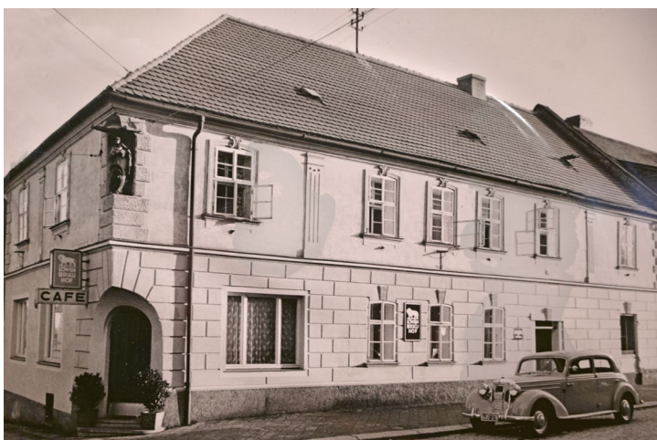
Blick von der Kolpingstraße auf das Hotel Zrenner (Archiv: G. Hofmann)
